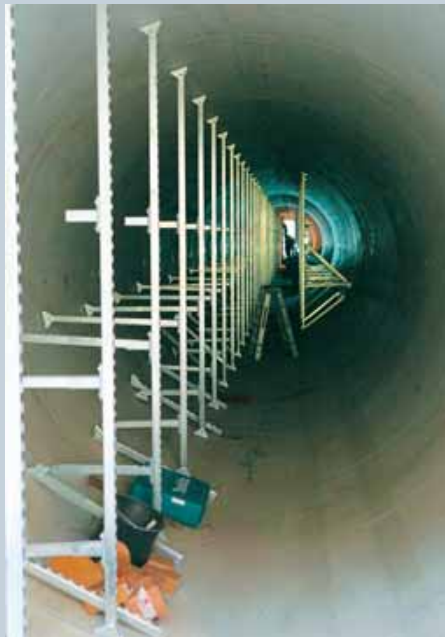
Ein flexibles und leicht begehbares Regalsystem mit übersichtlicher Anordnung der 21 unterschiedlich dimensionierten Leitungen.
