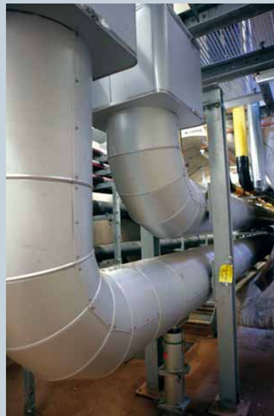
Blick in das Schachtbauwerk mit der Einmündung der mächtigen Fernwärmeleitungen aus der Vertikalen in den Infrastrukturkanal.
