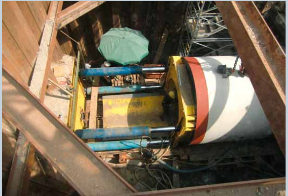
Blick in den Startschacht beim Vortrieb der Stahlbetonrohre DA 3 400.
