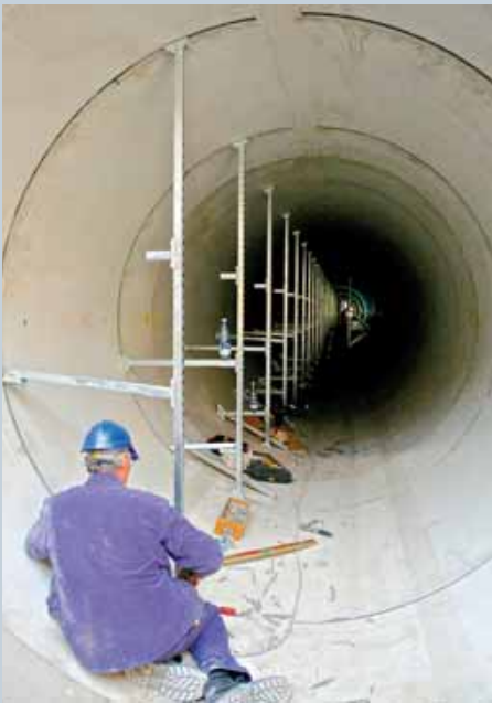
Ein flexibles und leicht begehbares Regalsystem mit übersichtlicher Anordnung der 21 unterschiedlich dimensionierten Leitungen.
