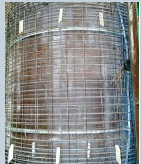
Ein stählernes Korsett: der maßgeschneiderte Bewehrungskorb.
