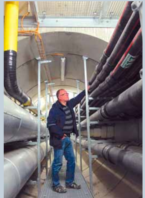
Ein flexibles und leicht begehbares Regalsystem mit übersichtlicher Anordnung der 21 unterschiedlich dimensionierten Leitungen.
