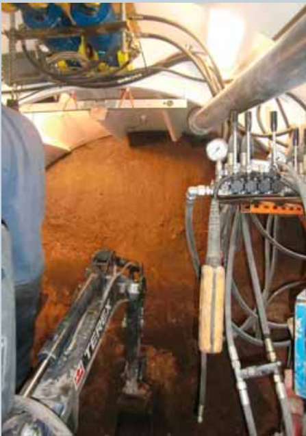
Der Vortrieb erfolgte in Schildbauweise mit offener Ortsbrust als „Haubenschild“.
